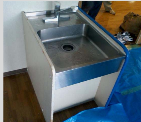
<写真の説明> 既設ステンレス製流し取り外し前
