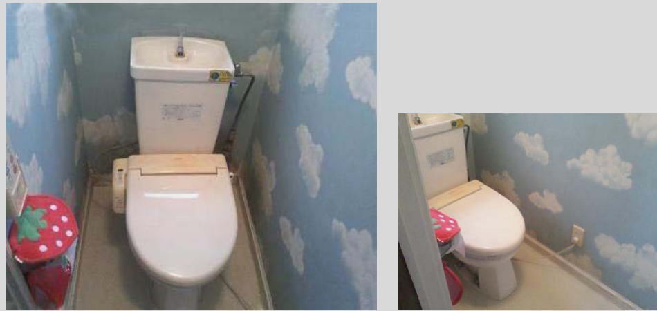
<写真の説明> 便器に凹凸が多く掃除が大変です
