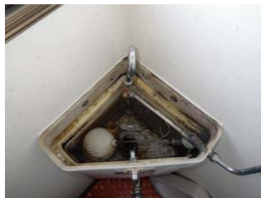
タンクの内部、部品形状がわかります
