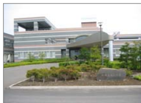
社) 北翔会 札幌あゆみの園 改築設備工事 平成12年 1月完成
