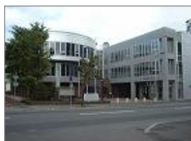
西健康づくりセンター・西区八軒 連絡所・地区会館建設空調設備工事平成 12年 9月完成
