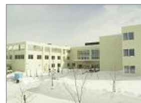
屯田北地区中学校 新築暖房衛生設備工事 平成17年 3月完成
