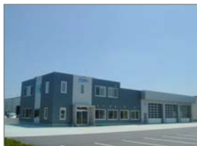
(株)イヤサカ札幌支店 新築暖房衛生設備工事 平成20年 7月完成
