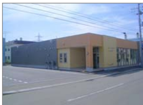
多目的ホール 新築暖房衛生設備工事 平成19年 6月完成
