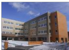
信濃小学校改築暖房衛生設備工事 平成19年 3月完成
