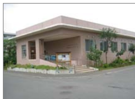
高齢者生活支援センターえみな 新築暖房衛生設備工事 平成14年 3月完成
