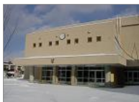
百合が原小学校 新築暖房衛生設備工事 平成14年 2月完成
