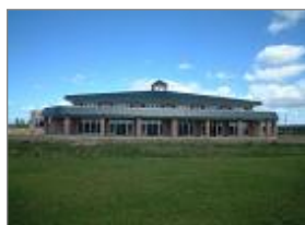
サッポロさとらんど多目的交流施設 新築暖房衛生設備工事 平成15年 9月完成
