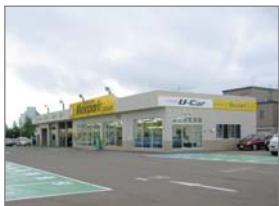
札幌トヨペット(株)マックスパーク 美しが丘店 新築暖房衛生設備工事 平成16年12月完成
