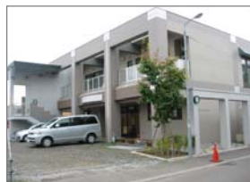
社) 札幌会 菊水ワークセンター 新築暖房衛生設備工事 平成16年 3月完成
