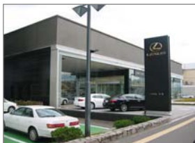
レクサス豊平店 新築暖房衛生設備工事 平成17年 5月完成
