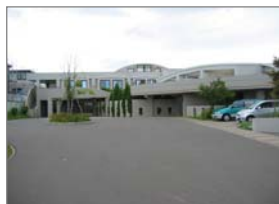
社)北海道リハビリ札幌ワークセンター 新築暖房衛生設備工事 平成11年10月完成
