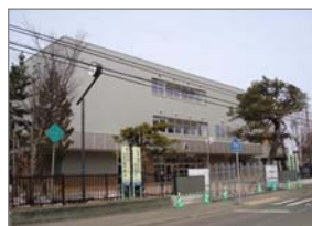
東白石中学校改築暖房衛生設備工事 平成20年 3月完成
