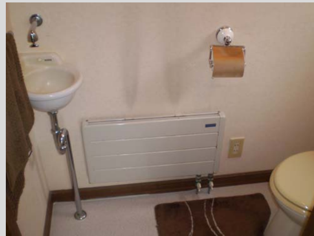
<写真の説明>手洗器と水栓金具の関係で使いづらくて、汚れが気になります。
